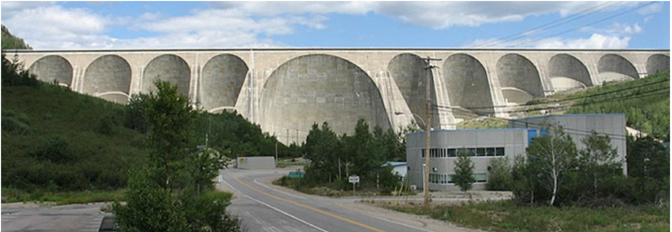
The Daniel-Johnson Dam – Image: Bouchecl , via Wikimedia Commons
