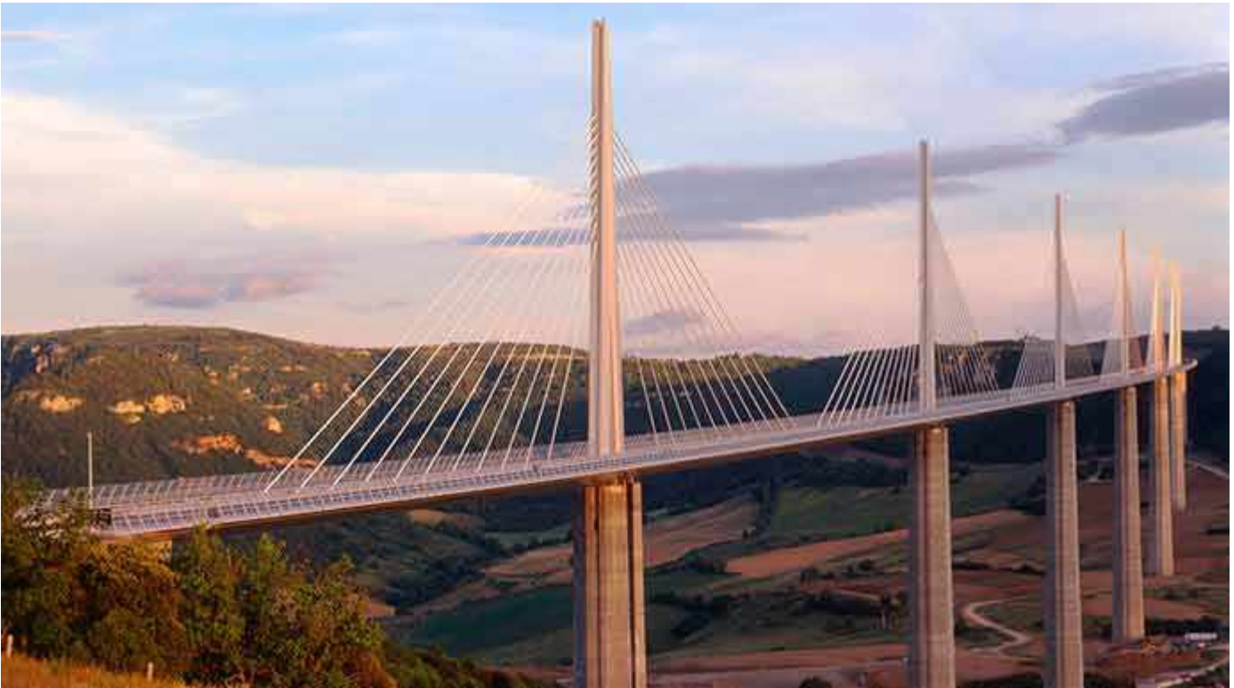
Viaduc de Millaut
