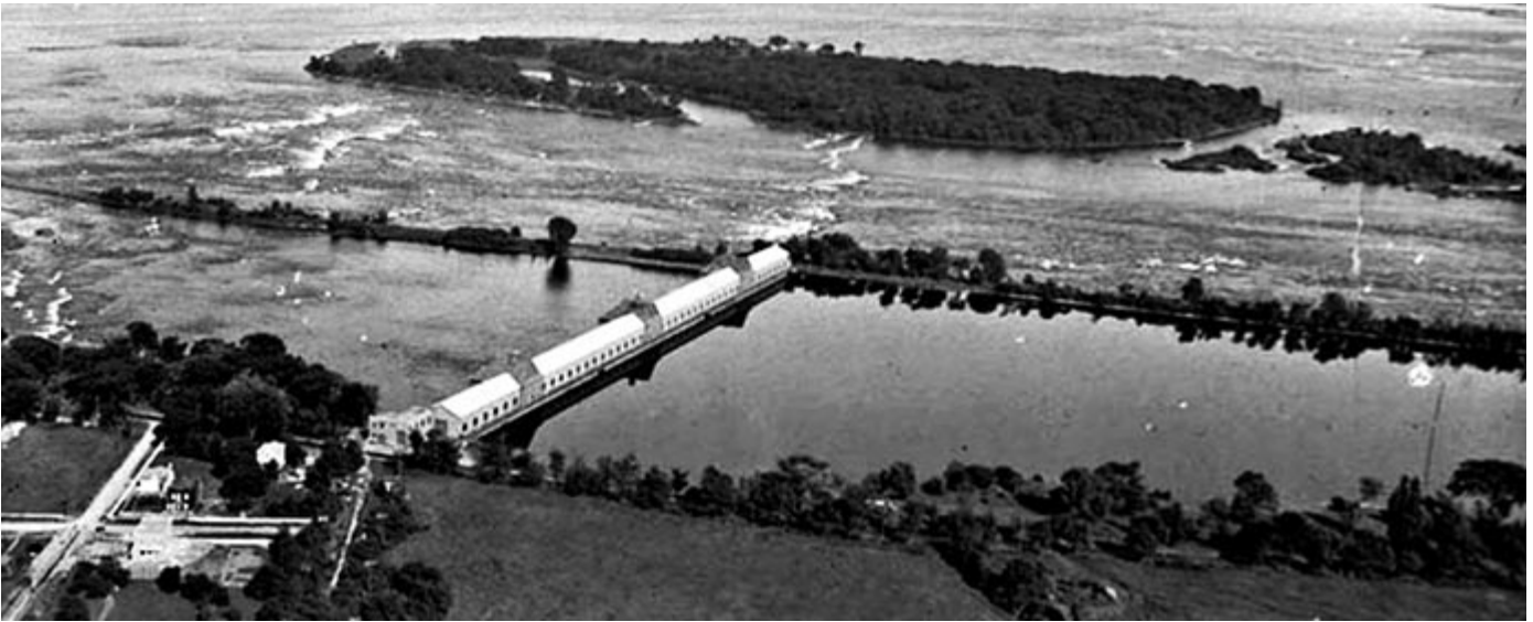
Le barrage hydroélectrique de Lachine • Image : Ministère des Terres et Forêts, domaine public, via Wikimedia Commons
