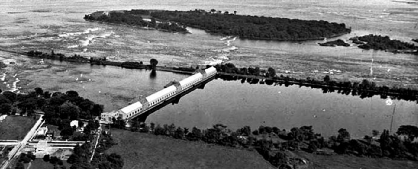
Lachine Hydroelectric Dam – Image: Ministère des Terres et Forêts, Public domain, via Wikimedia Commons
